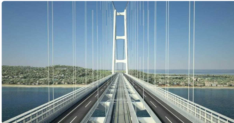
Ponte sullo Stretto
